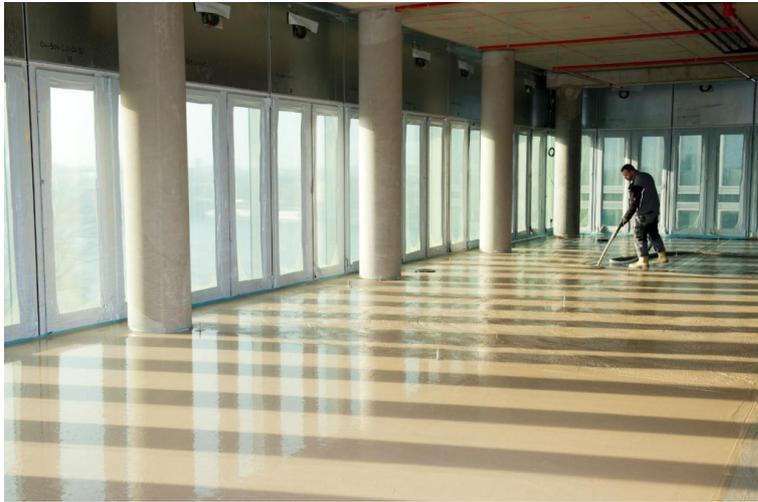
Mit der neuen Estrichnorm DIN 18560-1 gelten Calciumsulfatestriche früher als belegreif. Unnötige Verzögerungen im Bauablauf werden dadurch vermieden. (Foto: IWM e.V.)
