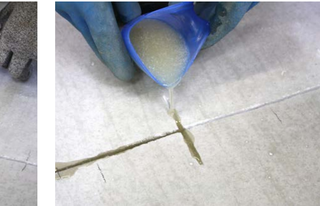
tief aufgeweitet und zusätzlich alle 20 cm quer zum Riss eingeschnitten.
