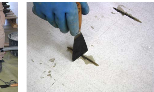
wie bei Variante B eingeschnitten für eine Querverdübelung (Wellverbinder).
