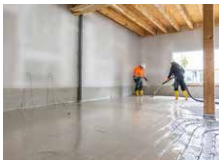
Abb. 2: Gleichmäßige Verteilung des Fließestrichs auf den Flächen
