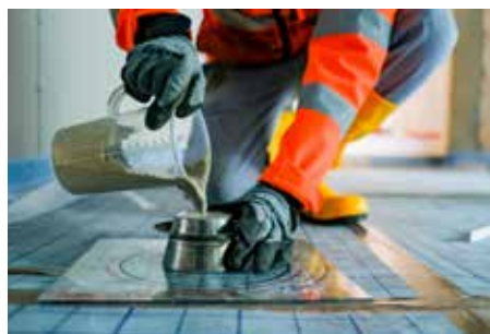
Abb. 4: Befüllung des Haegermanntrichters mit Fließestrich
