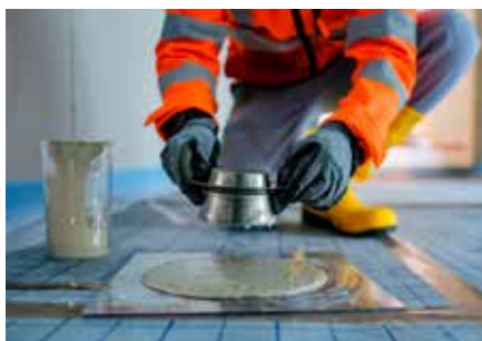
Abb. 5: Ziehen des Haegermanntrichters zur Prüfung des Durchmessers
