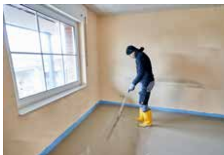
Abb. 3: Bearbeitung und Entlüftung mit einer Schwabbelstange
